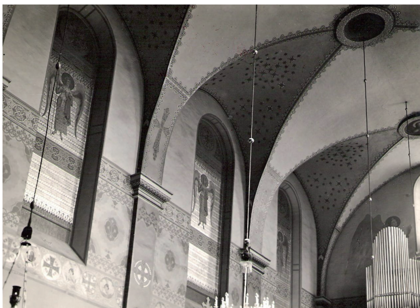
15. Cerkiew greckokatolicka p.w. Podwyższenia Krzyża Św. w Krakowie – malowidła nawy w kierunku chóru zachodniego, fot. z l. 30. XX w., Archiwum NAC w Warszawie
