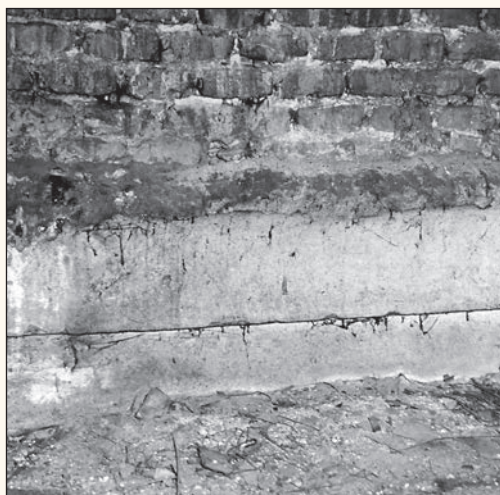
20. Strych budynku frontowego ze śladami tynkowanego profilowania pierwotnego gzymsu, widocznego pod stropem na ścianie tylnej budynku frontowego. Fot. z 1972 roku
