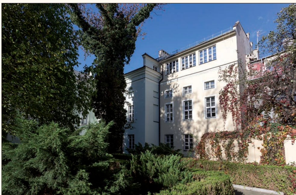
32. Drugi dziedziniec. Widok na oficynę południową. W jej wschodniej, cofniętej części, na ostatniej kondygnacji silnie przeszklona sala na terraria, nadbudowana w 1930 roku na potrzeby Zakładu Psychogenetycznego. Fot. Grzegorz Eliasiewicz
