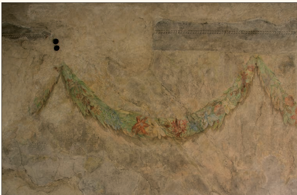
24. Fragment polichromii zachowanej w skrzydle zachodnim, w pomieszczeniu na pierwszym piętrze, pierwotnie należącym do Katedry Farmacji, ok. 1834-1836. Fot. Grzegorz Eliasiewicz
