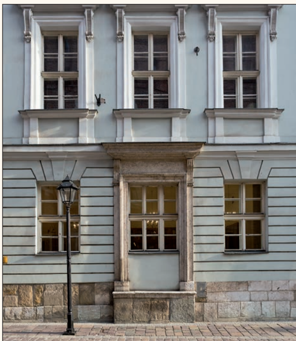
22. Portal pozostały po zamuirowaniu wejścia do tzw. tylnej sieni, pierwotnie prowadzącej przez skrzydło boczne do oficyny południowej. Fot. Grzegorz Eliasiewicz
