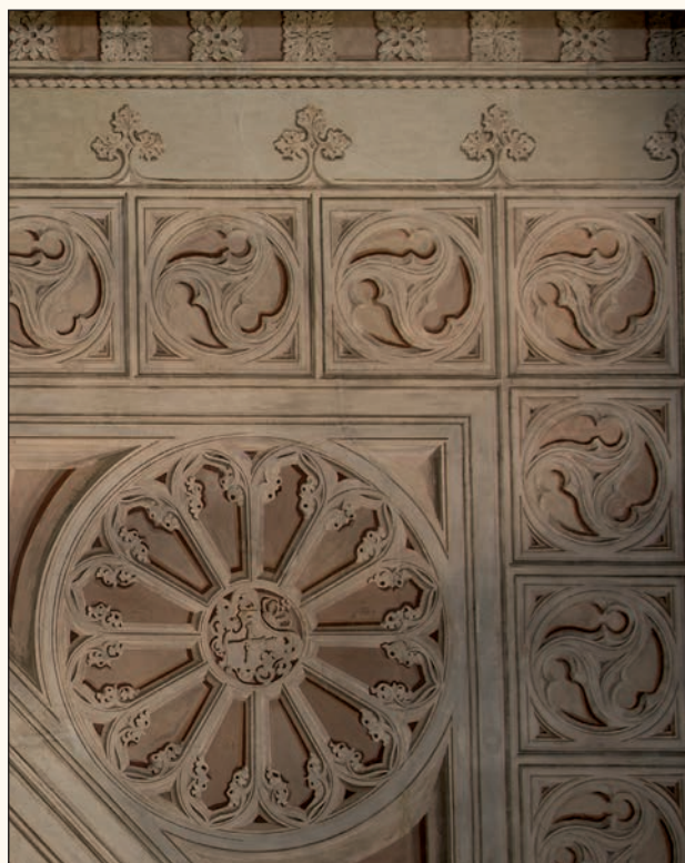
60. Detale polichromii sufitu sali środkowej pierwszego piętra budynku frontowego. Fot. Grzegorz Eliasiewicz
