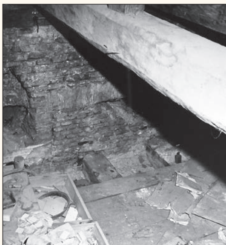
19. Strych budynku frontowego ze śladami pierwotnego zasięgu okien mezzaninu, widocznych w ścianie kolankowej fasady. Fot. z 1972 roku
