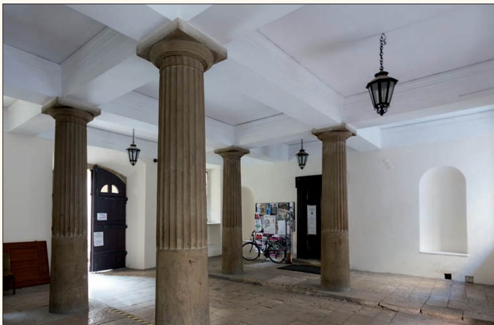
42. Sień budynku frontowego, przebudowana według projektu Tomasza Majewskiego w 1852 roku, widok w kierunku zachodnim. Fot. Grzegorz Eliasiewicz
