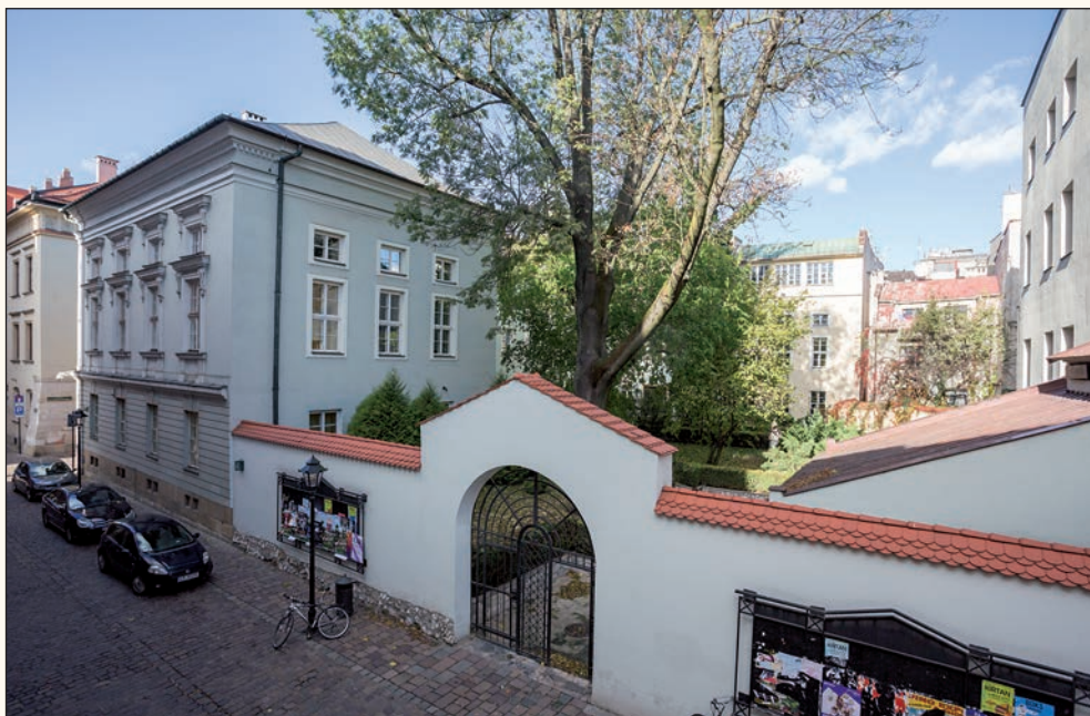
26. Widok na skrzydło tylne od strony południowo-wschodniej oraz na drugi, tj. południowy, dziedziniec. Fot. Grzegorz Eliasiewicz
