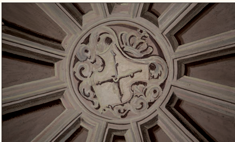
61. Detale polichromii sufitu sali środkowej pierwszego piętra budynku frontowego. Fot. Grzegorz Eliasiewicz
