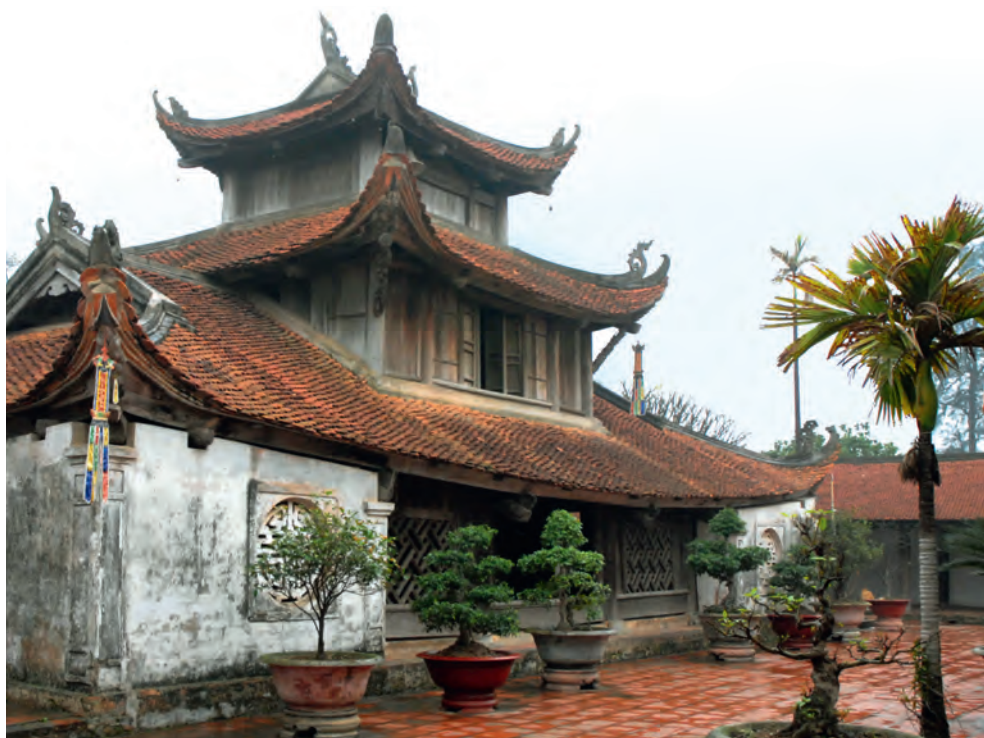
45. Centrum Luy Lâu, pagoda Bút Tháp, prowincja Bắc Ninh, Wietnam
