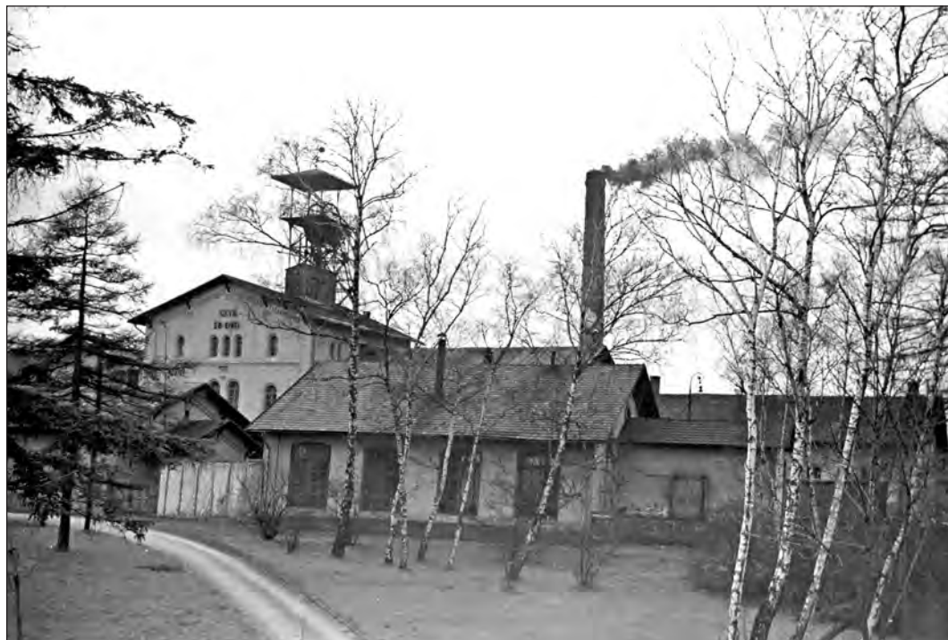
Fot. 12. Parowozownia na nadszybiu szybu św. Kingi
