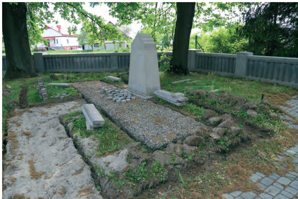
Fot. 12. Prace remontowo-konserwatorskie na terenie nekropolii w Zabawie. Prace wokół steli nagrobnej z piaskowca. Stan z maja 2022 r.
