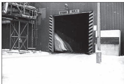
109. Rozbita przez czołg brama walcowni
