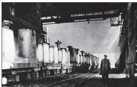
124. Transport gorących wlewków
