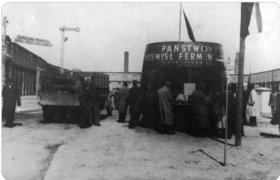
Ryc. 31 – budka z piwem Państwowego Zjednoczenia Przemysłu Piwowarsko-Słodowniczego Rejonu Zachodniego w Bydgoszczy, prawdopodobnie połowa 1946 roku.
