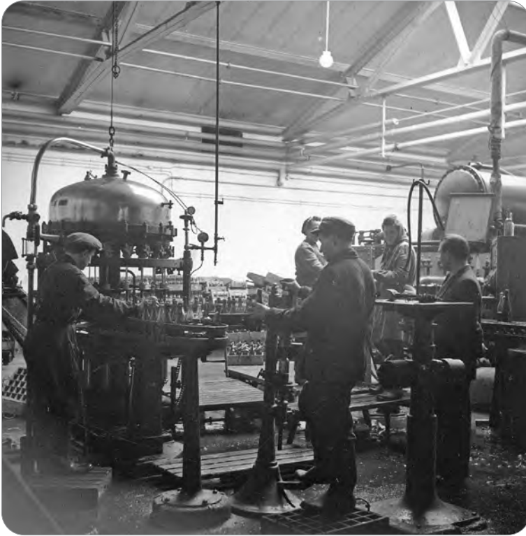
Ryc. 27 – linia do rozlewu piwa w butelki funkcjonująca przy browarze w Polczynie-Zdroju. Koniec lat czterdziestych.
