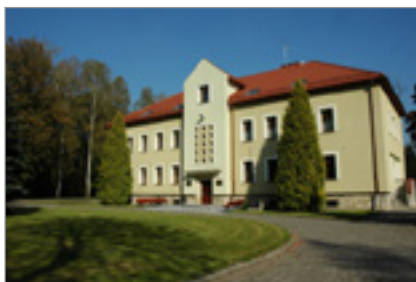
2. Budynek CMJW w Łambinowicach
