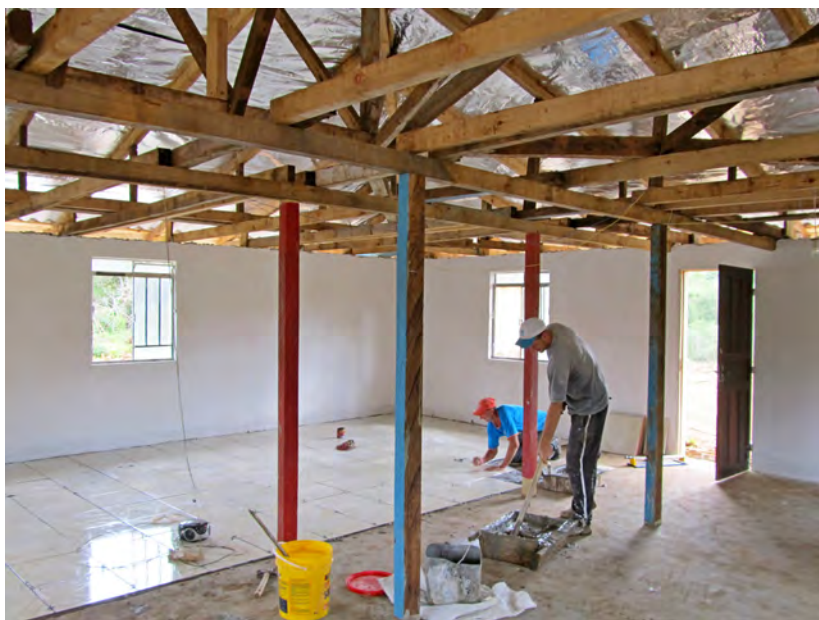
W49. Budowa murowanego domu Milczuków na Linha Iguaçu Norte (w okolicach Fartury). Ściany zewnętrzne zostały wymurowane, natomiast wewnętrzne zostaną wykonane z drewna. 2015 rok. Fotografował autor
