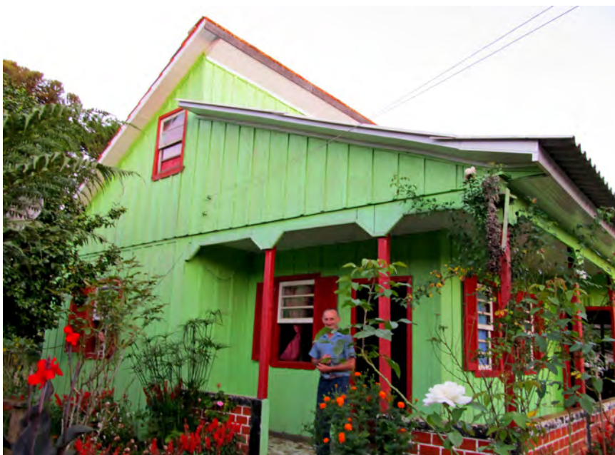
W59. Dom Fiałków na Linha Colônia Nova z dachem typu amerikano. 2015 rok. Fotografował autor
