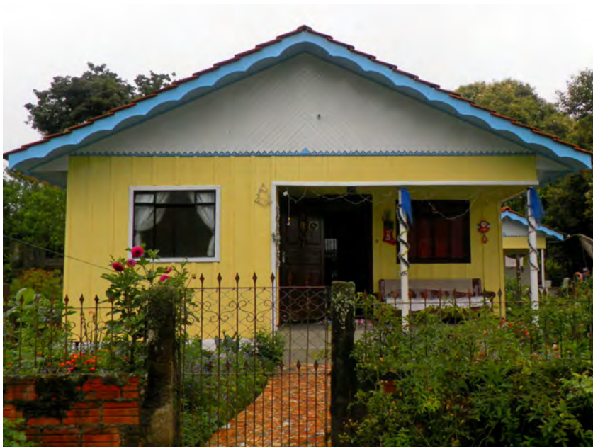
W64. Dom Kowalskich na Linha Divisa z dachem dwuspadkowym o nachyleniu ok. 25°. 2014 rok. Fotografował autor
