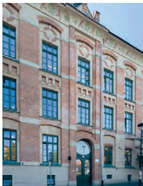
Budynek Szkoły Podstawowej nr 131 przy ul. Lubomirskiego 19. Fot. I. Stanisławski
