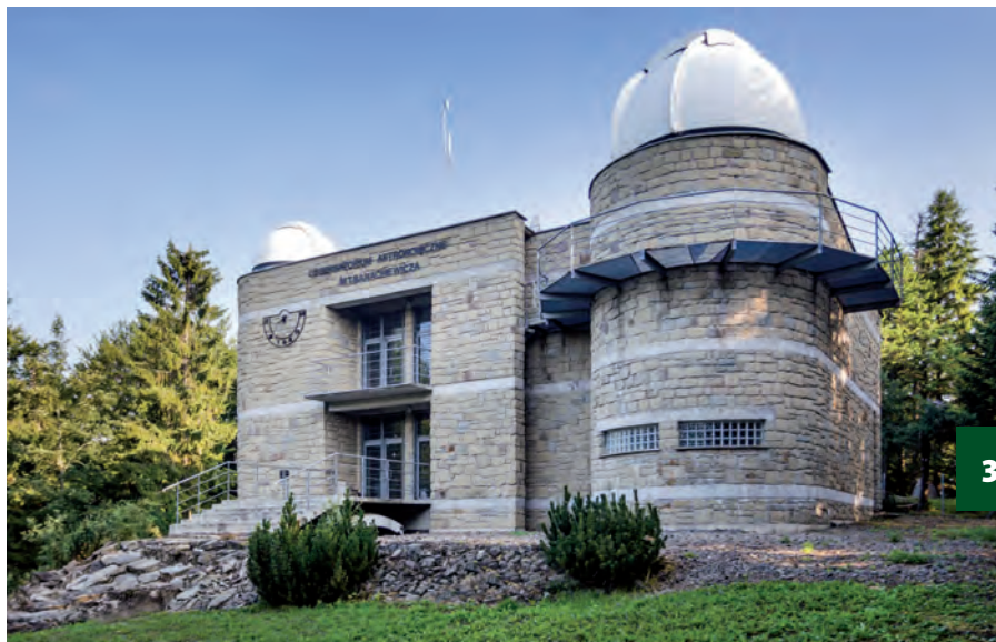
Obserwatorium astronomiczne na Lubomirze. Fot. I. Stanisławski
