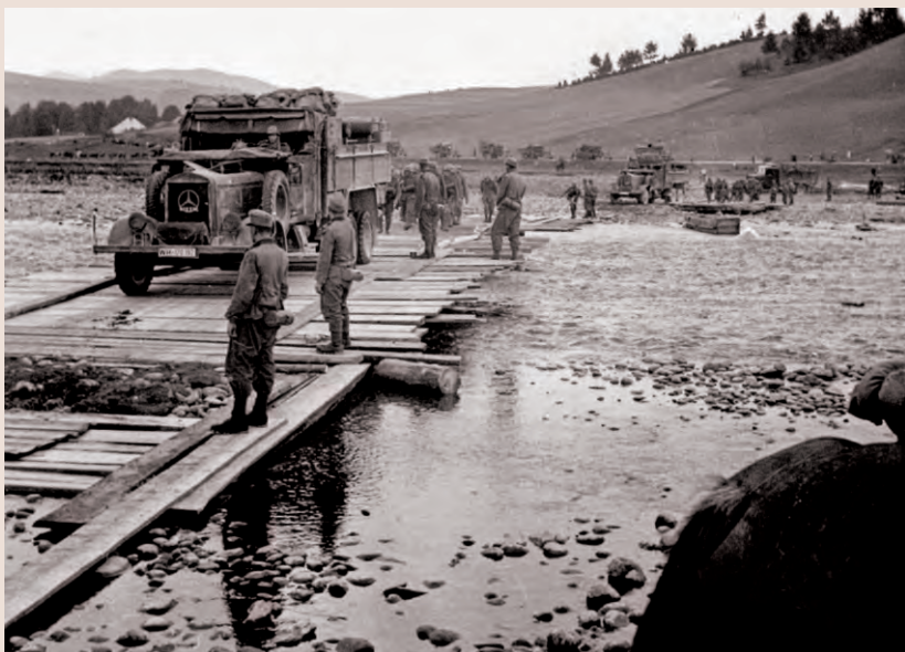
Prowizoryczna przeprawa przez graniczny Dunajec łącząca Łysą nad Dunajcem i Sromowce Wyżne, zbudowana przez batalion saperów 2 DG, 3 września 1939 r. Zbiory Anny Bik
