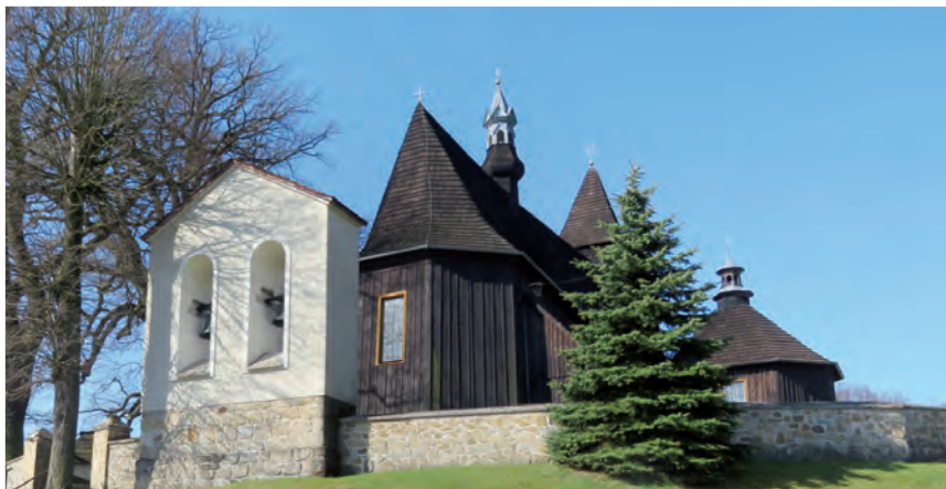
Kościół św. Marcina z Tours w Czeremnej. Fot. A. Bąk
